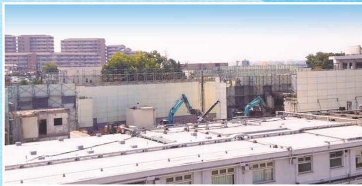
工事は進み11月半ばにB棟は、ほぼ解体が完了し、A棟の内装、外壁の解体工事へと進んでいます。工事に際しては、安全を重視し、建物の周囲を囲いとその上に防音壁を組み、解体は散水しながら防音、粉塵対策もした上で行われています。また、建物解体され、順次足場も撤去されています。足場の撤去に際しては、B棟A棟歩廊の通行制限をさせていただきますながら、通行される方の安全を確保してまいります。
